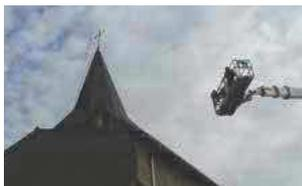
La pointe du clocher a été complètement refaite et nous avons également fait réaliser la pose d'un nouveau paratonnerre conforme à la réglementation en vigueur.
